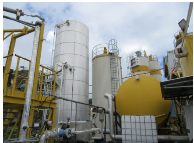
A gauche : Vue d'un termcotank en cours de vidange (brûleurs fioul installés) et cuve de fioul de 2000 l A droite : cuve principale de bitume de la centrale (cuve horizontale jaune)
