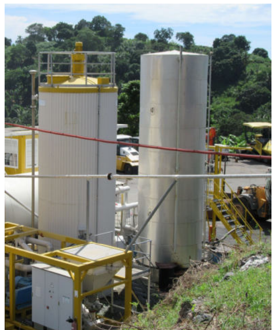
Ci-contre : cuve d'émulsion standard et cuve d'émulsion polymères
