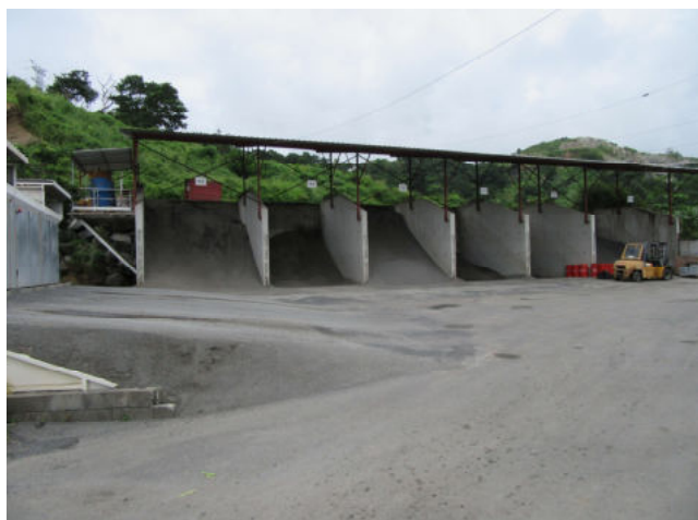
Racks de stockage des granulats (à gauche) et trémies de prédosage (à droite)
